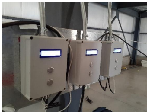
Fig. 5. Banco de tres Enoc, un controlador para cada tanque de fermentación.
