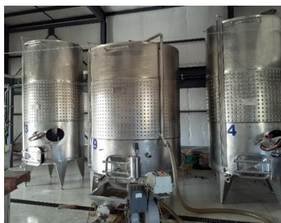
Fig. 6. Tanques de acero inoxidable de fermentación de jugo de uva.
